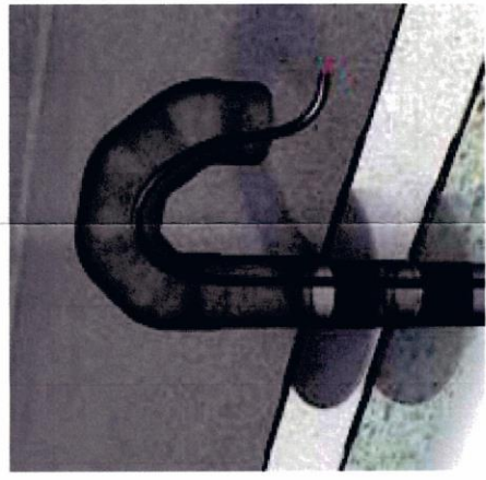
Przykład montażu - przejście dla przewodów i kabli - dwuczęściowe w dachu niewentylowanym
